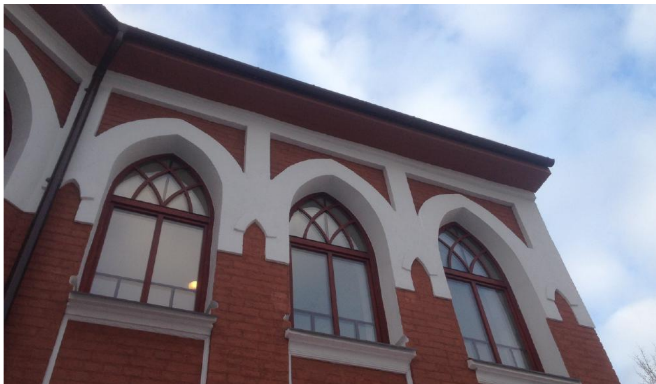
Рисунок 44.2. Дом Бибикова. Музей современного искусства. Фрагмент главного фасада. Стрельчатые окна второго этажа.
