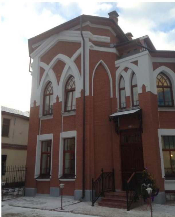
Рисунок 44.4. Дом Бибикова. Фрагмент восточного фасада
