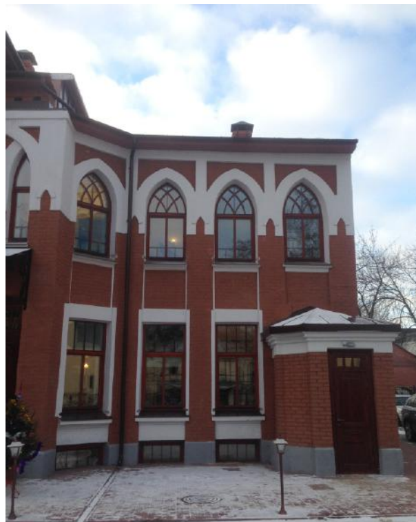
Рисунок 44.5. Дом Бибикова. Фрагмент восточного фасада
