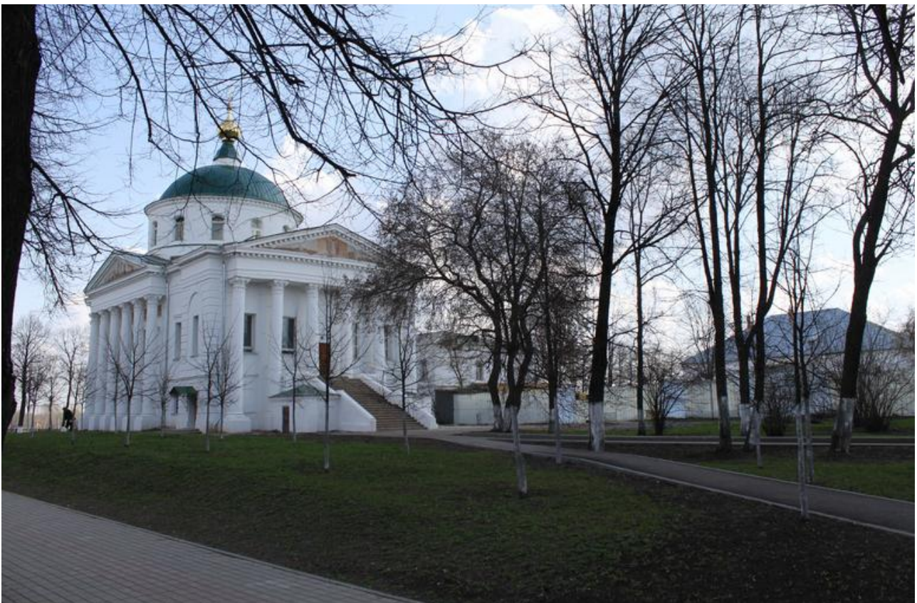
Рисунок 37.2. Ильинско-Тихоновская церковь. Западный фасад
