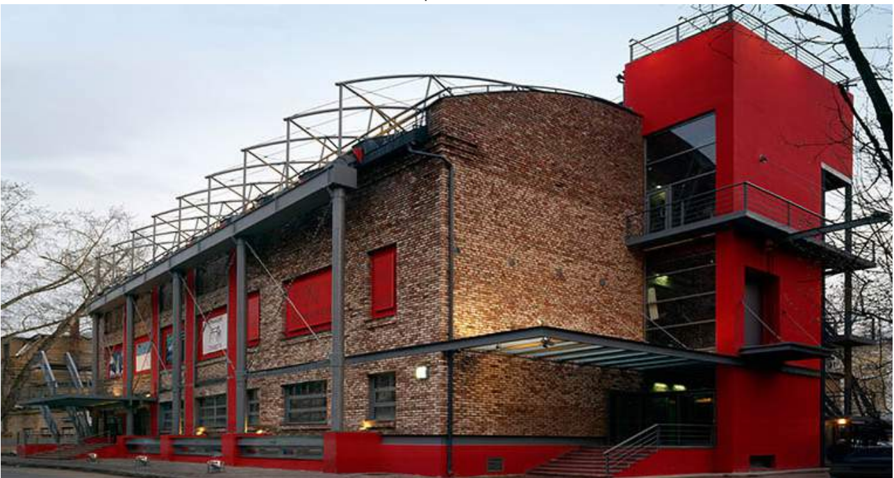
Рисунок 29.2. Государственный центр современного искусства. Москва. Пристроенный к зданию загрузочный лифт
