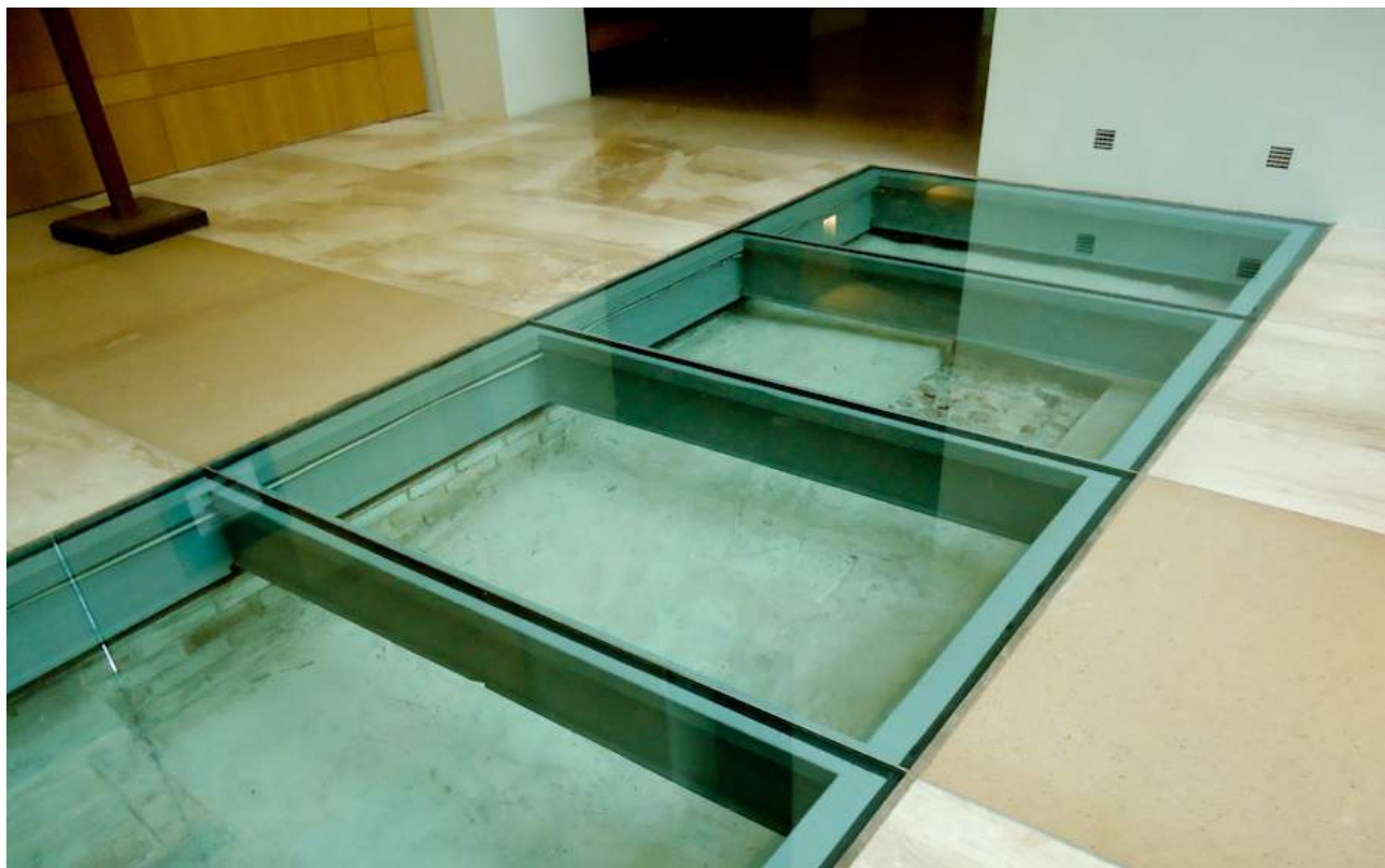
Рисунок 26.9. Главный штаб. Санкт-Петербург. Стекланный под открывает историческое сводчатое перекрытие
